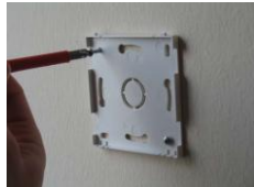
Izbušite odgovarajuće rupe na označenim mjestima. Plastičnim tiplima i vijcima učvrstite dno kutije na zid
